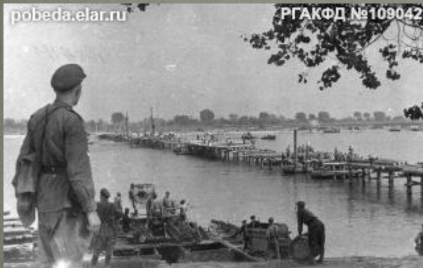
Строительство моста через реку Одер
